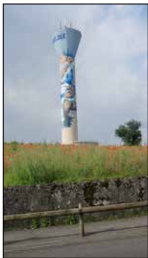
Le Château d'eau
